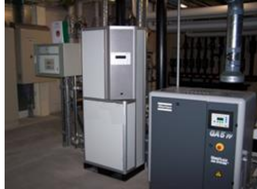
Zuurstofverlaging installatie
